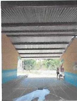
Foto 1: Ampleación de techado existente, continuando el techo con laminas y costaneras.
